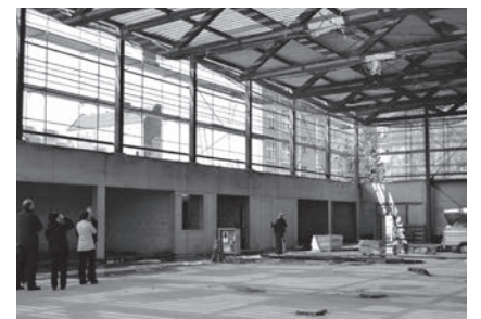
Die neue Quartiershalle entsteht Foto: Ilse Wolter
