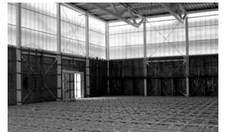
Mit Fußbodenheizung: die neue Quartiershalle in der Rütlistraße Fotos: QM Reuterplatz
